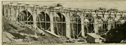
Abb. 129. Viaduct beim Nordwestbahnhof Iglau im Bau. [K. k. Staatsbahn Iglau-Neuhäus-Wessely.] [Nach einer photographischen Aufnahme von J. Haupt, Iglau.]
